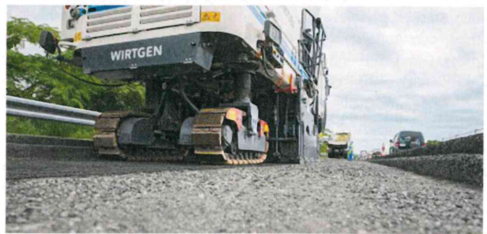
Kaltfräsen wie die W 210i tragen durch das selektive Fräsen von Deck-, Binder- und Tragschicht und intelligente Frästechnologien dazu bei, dass das ausgebaute Material in der Asphaltmischanlage besonders wirtschaftlich recycelt werden kann
