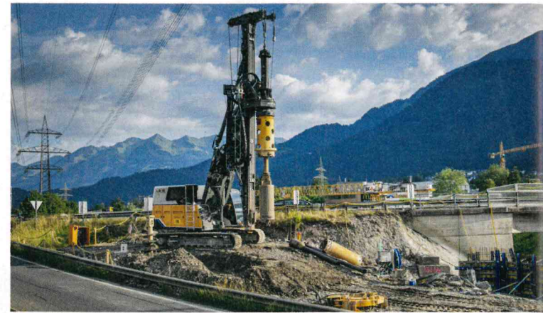
Beim Baustelleneinsatz an der Anschlussstelle der A14-Autobahn Bludenz-Bürs konnte die Praxistauglichkeit des Drehbohrgeräts LB 16 unplugged unter Beweis gestellt werden
