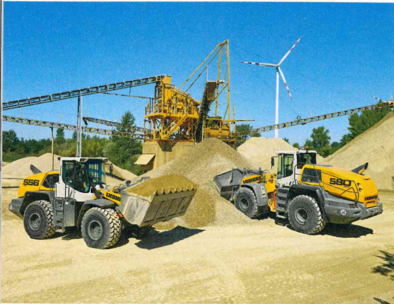
Die beiden XPower-Radlader sollen zusätzliche Leistungssteigerung im Betonwerk Lahofer bringen
